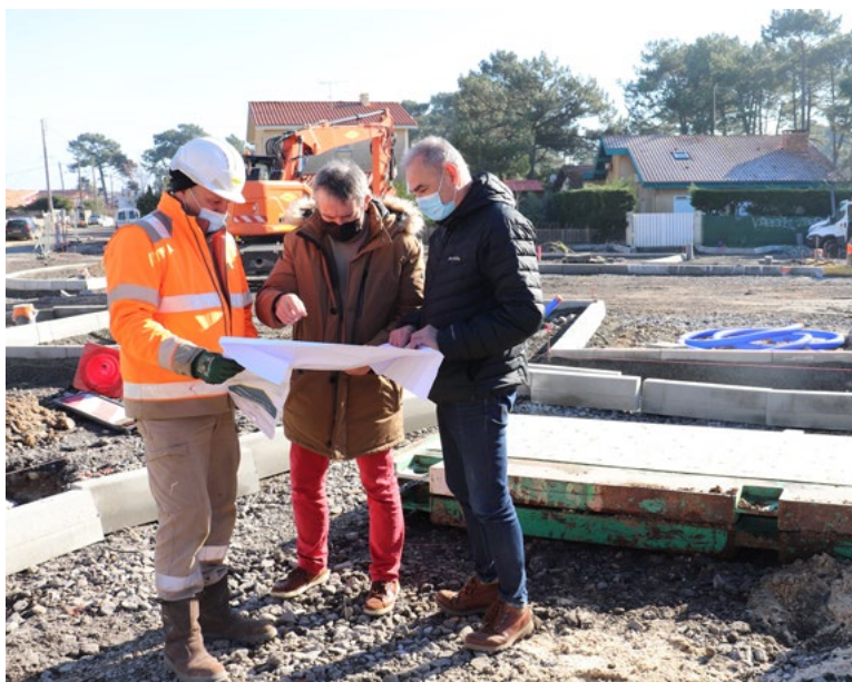
Réunion de chantier sur la place des Basques en présence de Jean-Luc Aschard.
