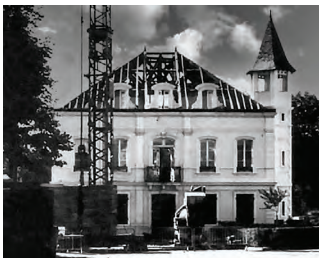
1984-Travaux de rénovation de la villa de Monseigneur.
