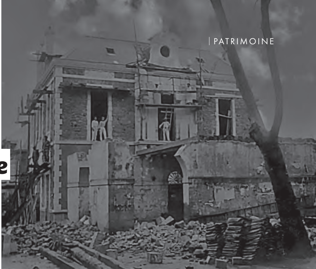
1906-1907-Démolition de l'ancienne mairie et construction de la nouvelle.
