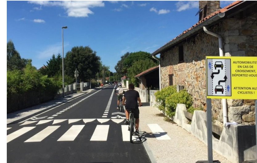
Chaussée à voie centrale banalisée sur la commune de Bénesse-Maremne
