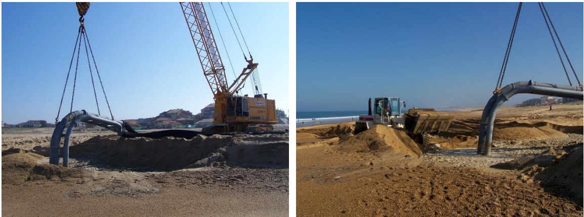
Figure 9: Extraction des sables sur la plage Notre-Dame à l'aide de la dragline et de l'hydroéjecteur.
