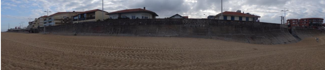
Figure 17: Ouvrages de défenses sur le front de mer (source : CASAGEC INGENIERIE, 2016).
