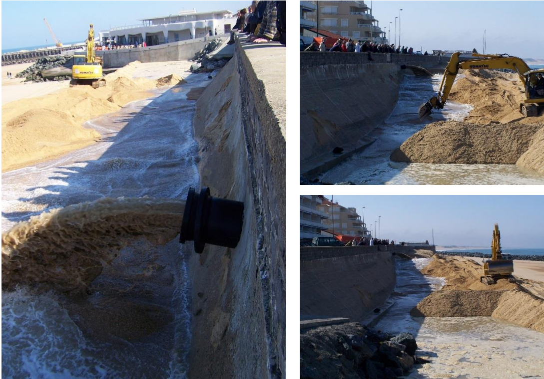
Figure 10: Refoulement des sables sur les plages du front de mer par les conduites disposées le long du boulevard de front de mer.
