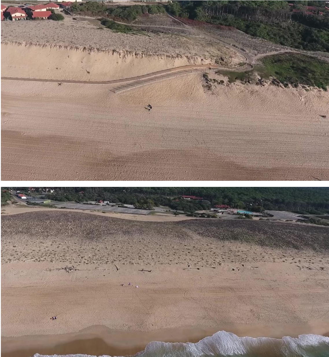
Figure 21: Octobre 2016, exemple de déploiement de filet coco (en haut) et restauration dunaire (en bas) sur la commune de Capbreton (source : commune de Capbreton).
