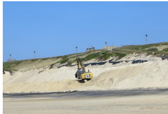
Figure 12: Exemple d'extraction, chargement, transport, dépôt et régalinge de sables sur le cordon dunaire de la plage de Biscarrosse. Mars 2014.
