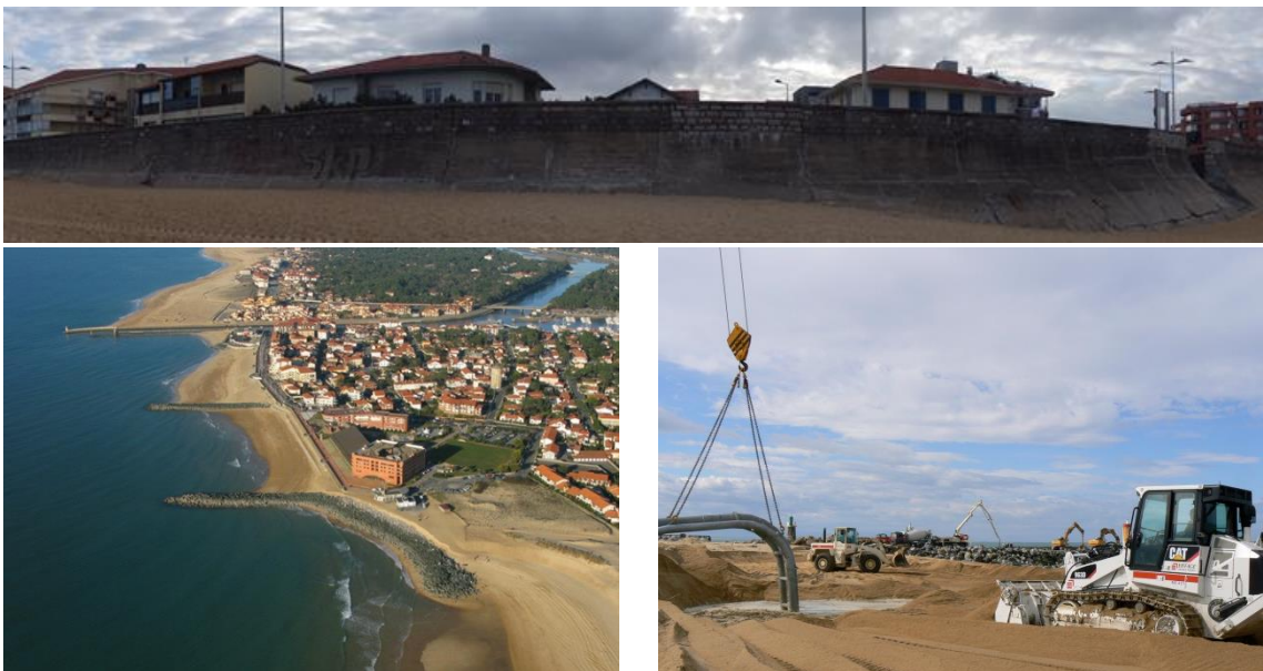
Figure 2: Dispositifs mis en place sur les plages de Capbreton (en haut : perrés longitudinaux, coin gauche : les épis, coin droit : le rechargement).
