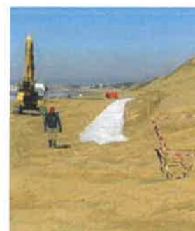
Figure 23. Pose du boudin géotextile au droit de la STEP
