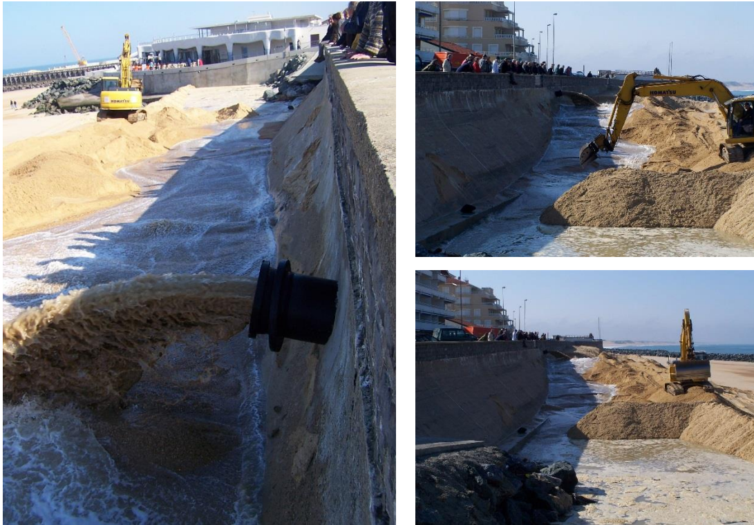
Figure 9: Refoulement des sables sur les plages du front de mer par les conduites disposées le long du boulevard de front de mer.
