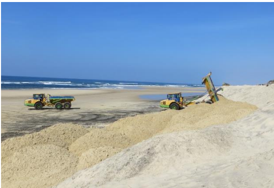
Figure 11: Exemple d'extraction, chargement, transport, dépôt et régalinge de sables sur le cordon dunaire de la plage de Biscarrosse. Mars 2014.
