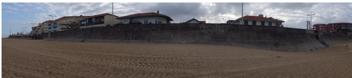
Figure 15: Ouvrages de défenses sur le front de mer (source : CASAGEC INGENIERIE, 2016).
