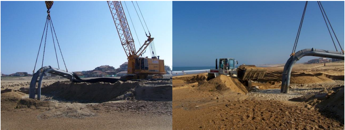
Figure 8: Extraction des sables sur la plage Notre-Dame à l'aide de la dragline et de l'hydroéjecteur.
