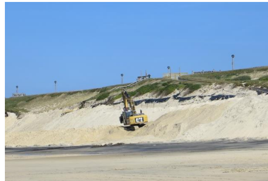
Figure 11: Exemple d'extraction, chargement, transport, dépôt et régalinge de sables sur le cordon dunaire de la plage de Biscarrosse. Mars 2014.
