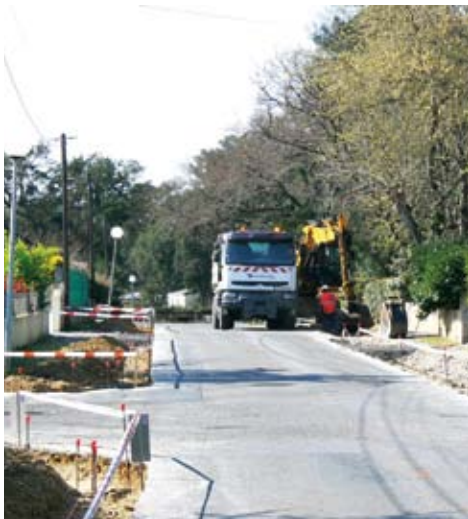
Aménagement de la rue des Chevreuils en voie partagée (piétons, cyclistes, voitures)
