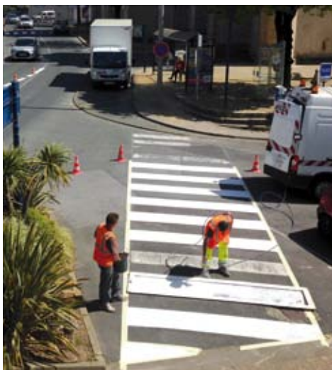
Travaux d'entretien du marquage au sol devant la mairie
