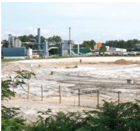
Le chantier de la nouvelle UVE a démarré
