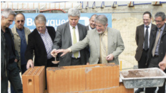
La 1 re pierre du programme "l'Estacade" a été posée fin mars sur les fondations de ce qui deviendra un centre de balnéothérapie de 1 600 m 2 , une résidence de tourisme de 52 logements, 67 appartements en accession à la propriété et 1 commerce
