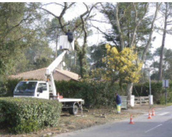
Élagage des chênes rue Montesquieu, en face de l'école maternelle Saint-Exupéry
