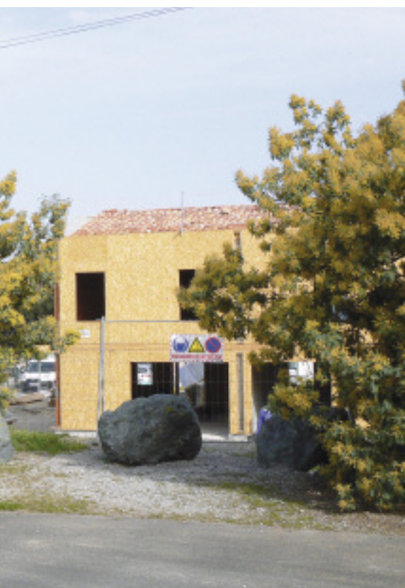
Dans un premier temps, les locataires des HLM "Le Boudigau" seront accueillis dans les nouveaux logements actuellement en construction entre les HLM "Les Mouettes" et "La Palombière"
